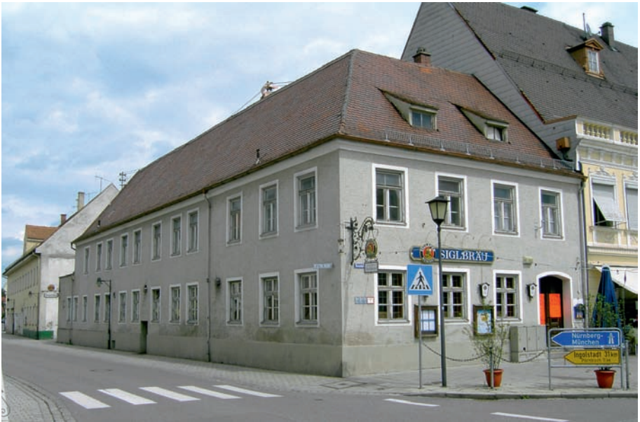
Der jüngst abgebrochene Siglbräu war eines der Gebäude, die nach dem großen Brand von 1813 wieder neu aufgebaut wurden (2006).
