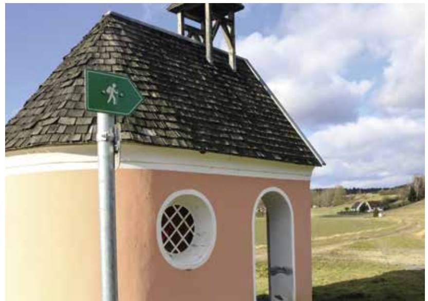
Der 15,4 Kilometer lange Panoramaweg Nord führt gleich an mehreren Ortsteilen vorbei. Bei Angkofen lädt die kleinen rosa Kapelle „Königin des Friedens“ dazu ein, kurz innezuhalten. Im weiteren Verlauf der Wanderstrecke bietet sich immer wieder Aussicht auf Gittenbach, Ehrenberg und Tegernbach.
