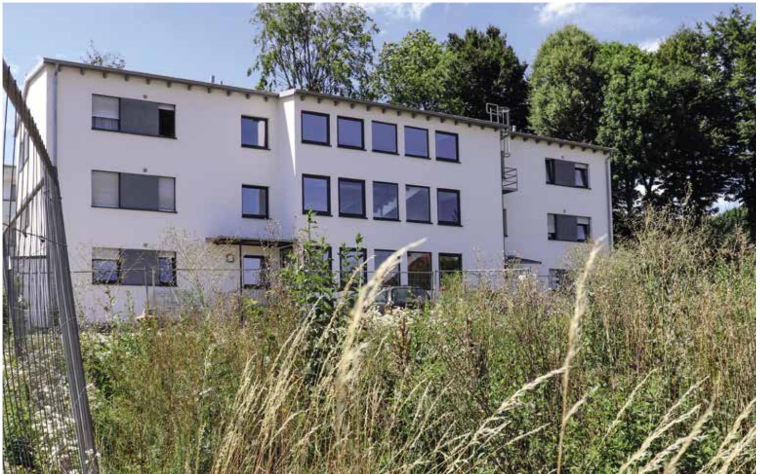
In der Ziegelstraße entstehen 15 Wohnungen im geförderten Bereich.
