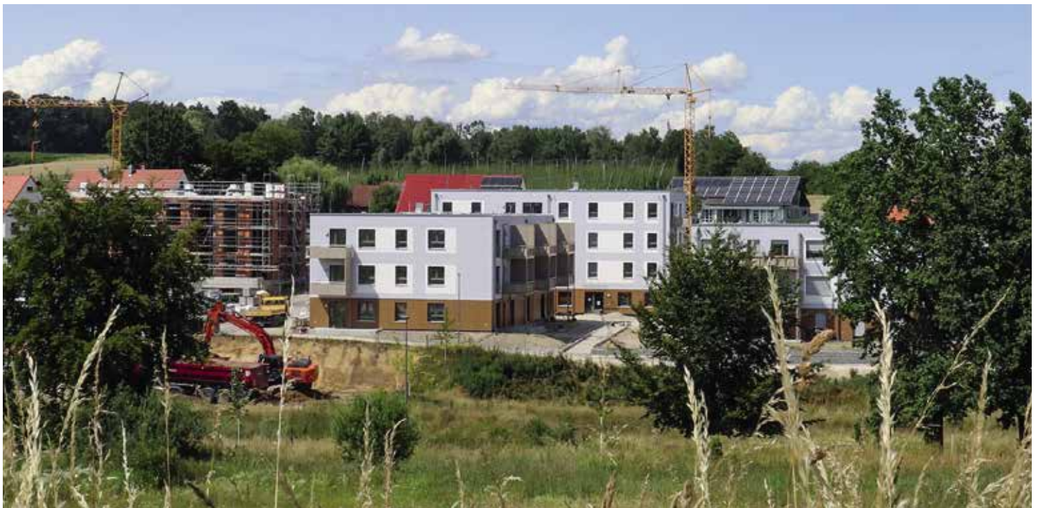
In Heißmanning sind 30 Wohneinheiten in Modulbauweise entstanden.
