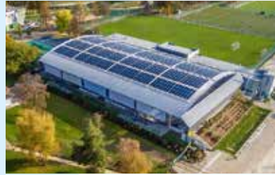
Das komplett sanierte Eisstadion mit der großen Photovoltaikanlage aus der Vogelperspektive
