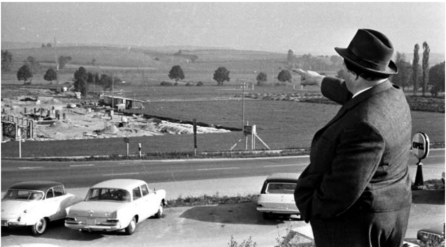
„Da geht’s lang!“ Architekt Heinrich Ponn dirigiert die Abläufe auf „seiner“ Baustelle an der Ingolstädter Straße [1969].
