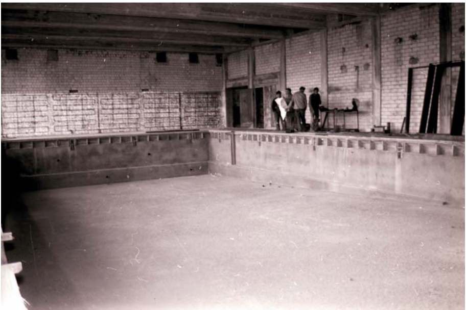
Bauphase des Hallenbads beim 1966 bis 1968 errichteten Gymnasium an der Scheyerer Straße [1967]
