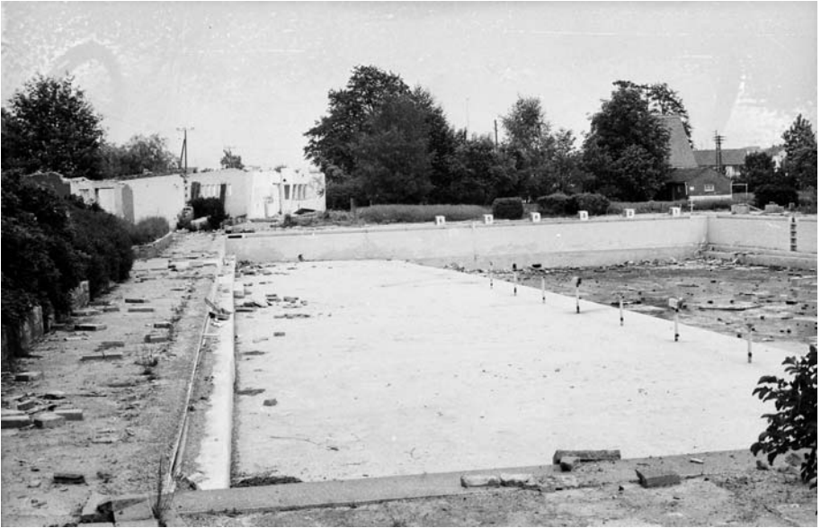
Die Abbrucharbeiten begannen nach der letzten Badesaison 1970, die nochmals hohe Besucherzahlen bot.
