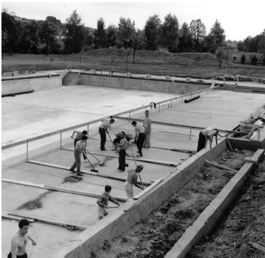
Das neue Becken mit gemauerten Treppen und Starterblöcken nimmt Konturen an. Mitarbeiter der Wasserwacht sorgen für den letzten Feinschliff [1955].
