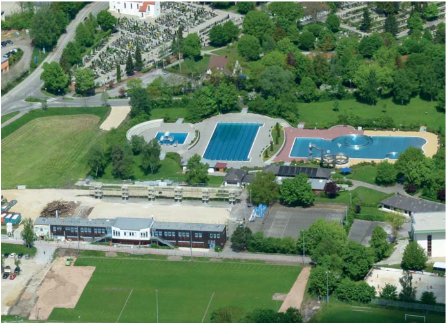
Nach einer umfassenden Sanierung in den Jahren 2000 und 2001 präsentierte sich das Freibad in neuem Gewand, die ursprüngliche Gestalt blieb erkennbar (2001).
