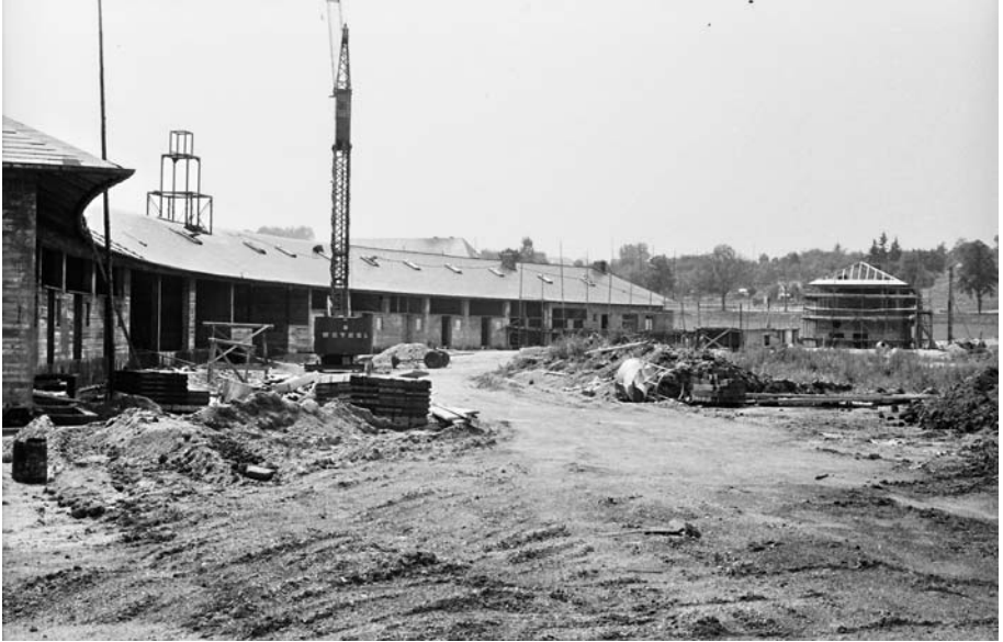
Die halbrunden Bauten am Eingangsbereich mit Umkleebereichen und Räumen für die Wasserwacht in der Bauphase (1970)
