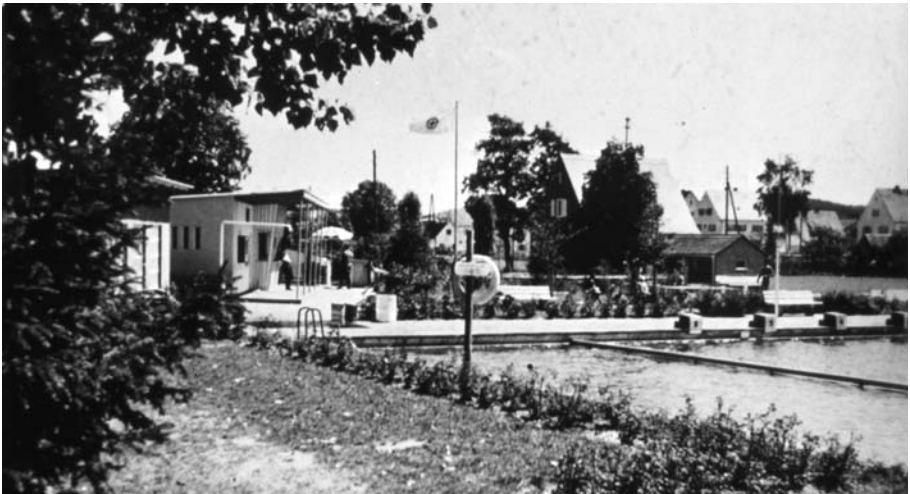
Eingangsbereich und Becken des Bads Mitte der 1950er Jahre
