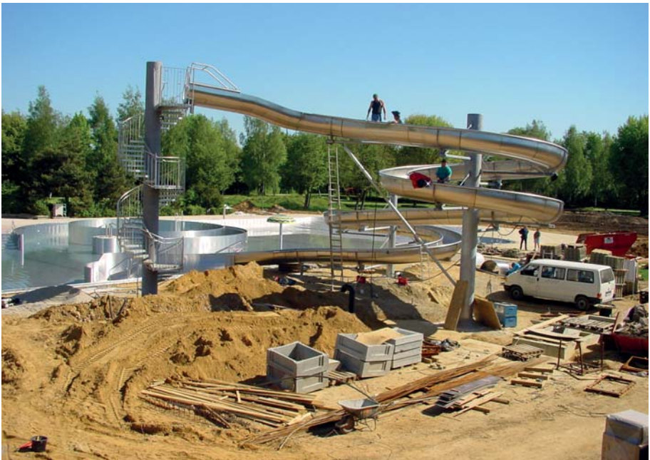
Einbau der 77 Meter langen Erlebnistrutsche, die zu einer besonderen Attraktion werden sollte (2000)
