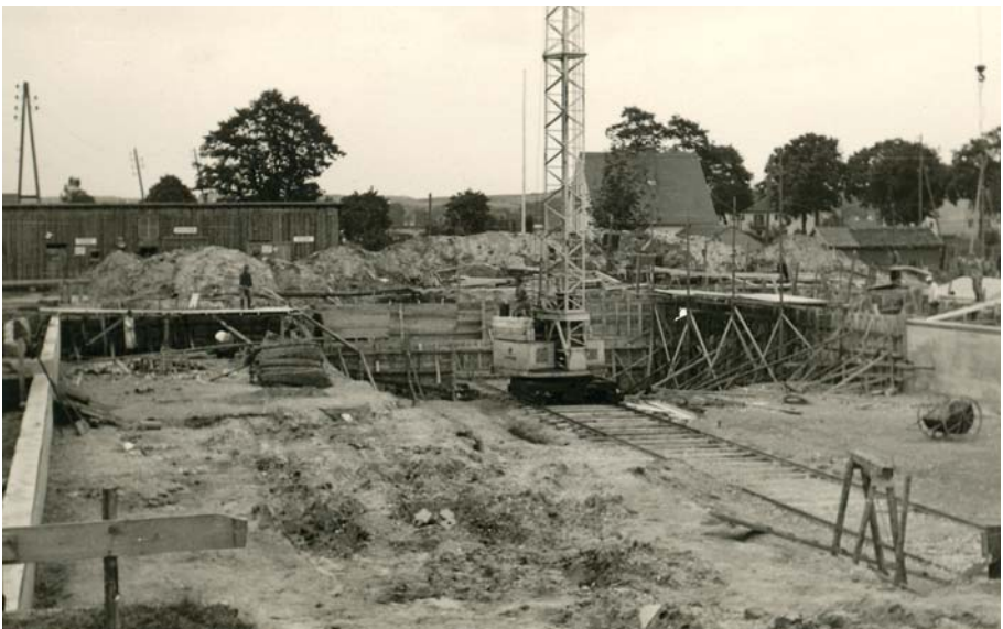
Im Sommer 1954 liefen die Umbauarbeiten zur Schaffung eines ausbetonierten Beckens auf Hochtouren, die Badesaison fiel aus.
