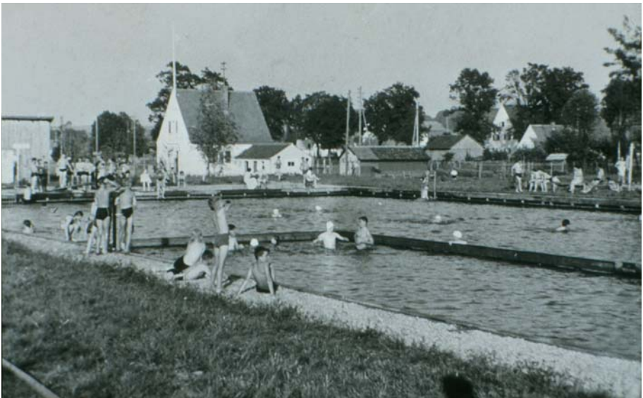
Badebetrieb in den frühen 1950er Jahren mit der damaligen Bebauung im Hintergrund
