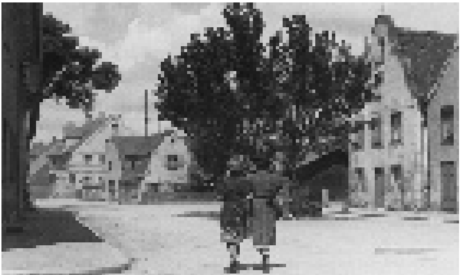
Blick in die Frauen- und Türltorstraße mit noch alter Bausubstanz (1950er Jahre)
