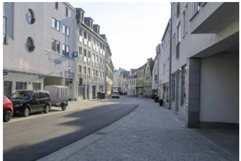
Aus Alt mach Neu: Enge, schmale Gehwege gehören der Vergangenheit an. Für die extra breiten Gehwege wurde auf Borde verzichtet.
