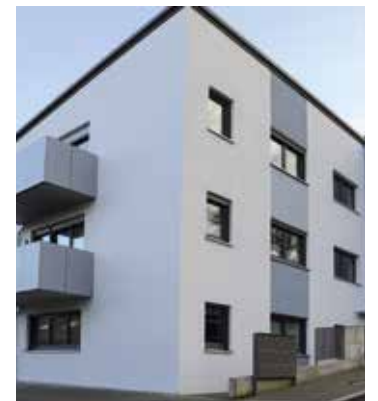
24 neue Wohnungen wurden 2022 in der Stettbergstraße fertiggestellt.
